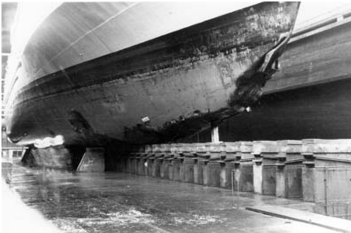
Skader på FYENS Skrog. Til venstre skibets stævn og til højre trykkede plader i akselgangen. Trods den efterfølgende reparation af skibet forvandt det aldrig skaderne helt. FYENS topfart nåede aldrig samme niveau som før grundstødningen, og maskineriet blev plaget af en række lyde, som ikke havde været der før den 7. marts 1979. (Marinens Biblioteks arkiv)
