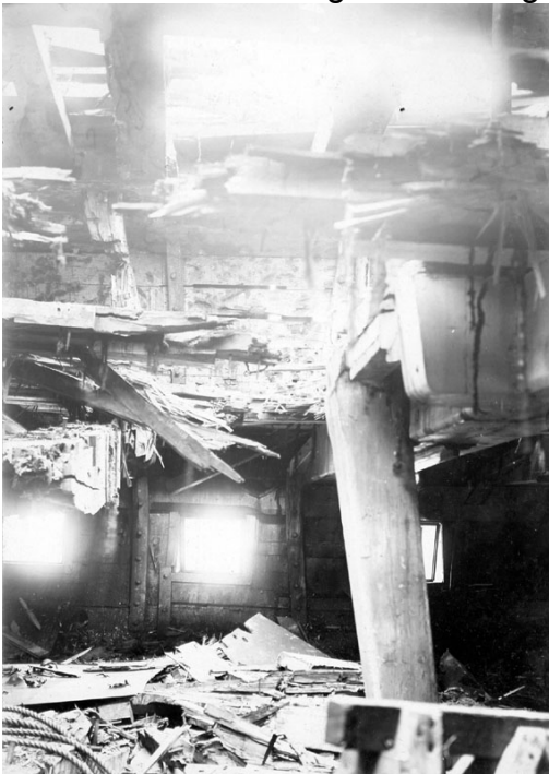
Billede 16: Det ødelagte dæk fotograferet nedenfra.
