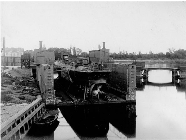
Havhesten i dok. Bemærk skaden på torpedobådens bagbords side.
