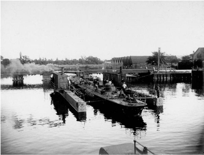
Torpedobåden er her på plads, og der gøres klar til at tømme flydedokken for vand.
