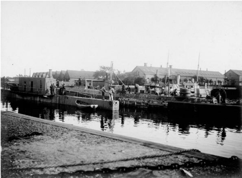
Havhesten på vej ind i flydedokken. Den midlertidige lapning af skaden på bagbord side ses tydeligt.
