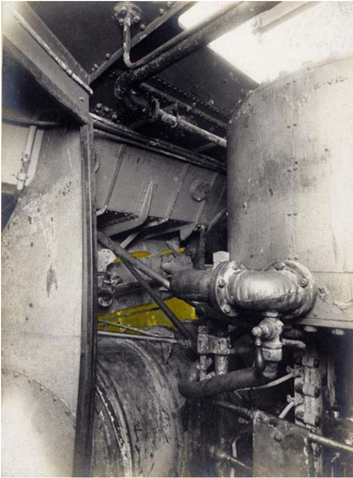
Et udsnit af skaden set fra maskinrummet.
