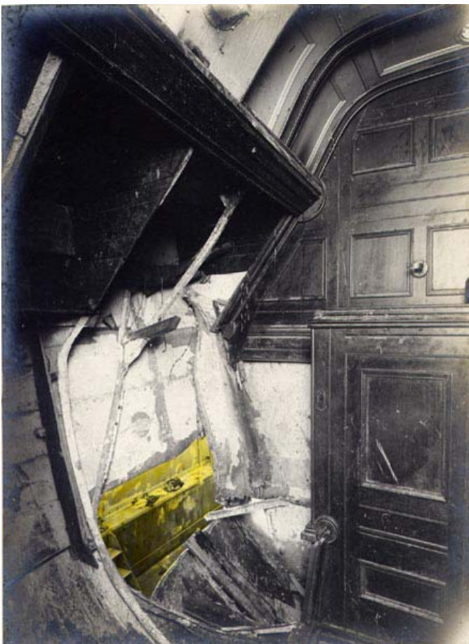
Et udsnit af skaden set indenfra.
